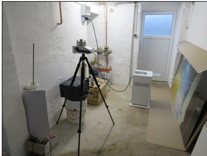
Abb. 1: Versuchsraum mit Luftreiniger XG 500
